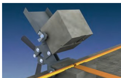
Soldadura aluminotérmica.
